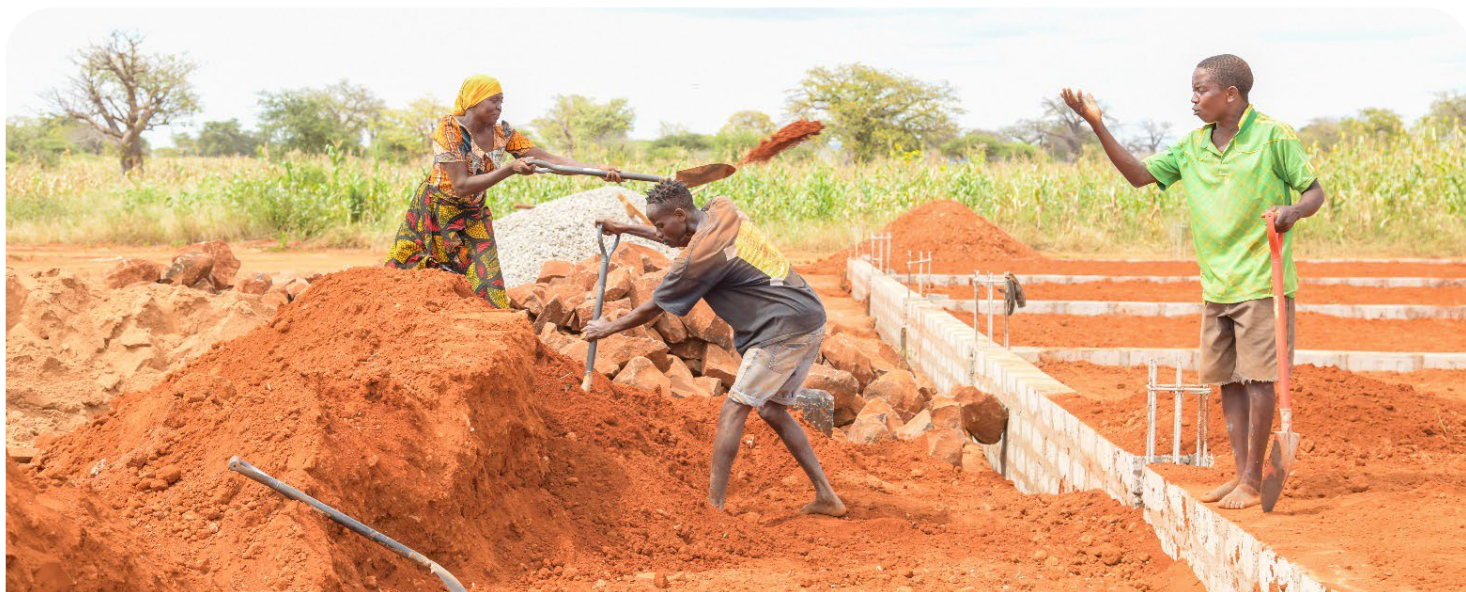
Wananchi wa Kijiji cha Bwawani wakishiriki Ujenzi wa Chuo cha VETA cha Wilaya ya Chamwino.
